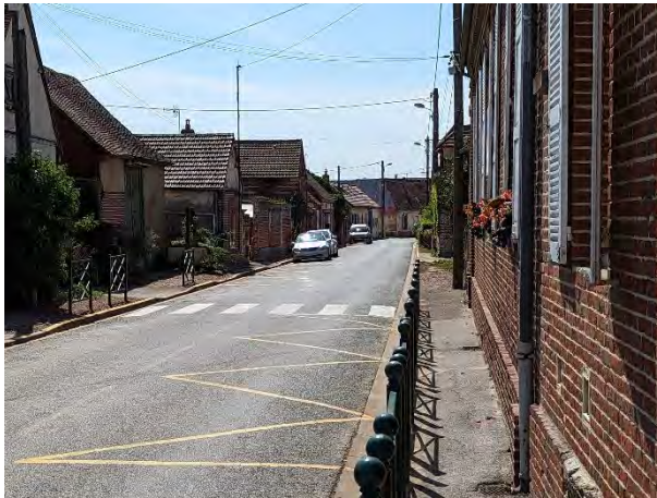
Des cheminements trop étroits
