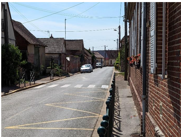
Des cheminements trop étroits
