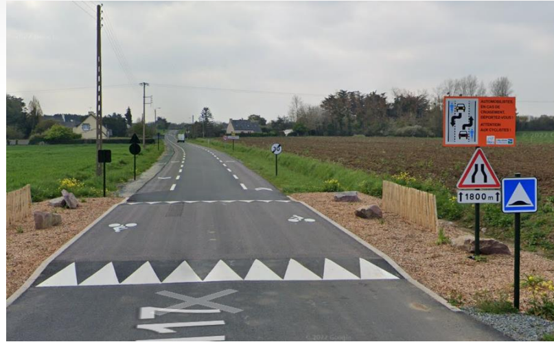
Exemple d'aménagement d'une CVCB hors agglomération (Fréhel, Bretagne)
